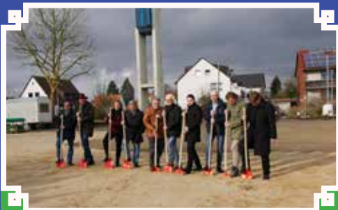
2020 Erster Spatenstich für das neue Gemeindehaus
